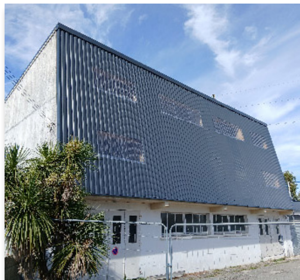
Rénovation du toit de la Maison de la Solidarité à Nivillac avec désamiantage
